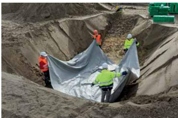
Achten Sie darauf, das Vlies mit einer ausreichenden Überlappung quer zur Grabenlängsachse zu verlegen. Hierbei gilt die Formel: Rigolenumfang + min. 0,50m Überlappung = Vliesbahnen.
