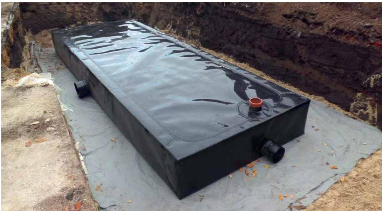
Die gesamte Rigole wird vollständig mit einem Filtervlies (Empfehlung: GRK 3, 200 g/m<sup>2</sup>) umhüllt, um das Eindringen von feinen Bodenanteilen (Sand etc.) zu verhindern. Hierzu legen Sie zunächst die gesamte Baugrubensohle mit Vlies aus.
