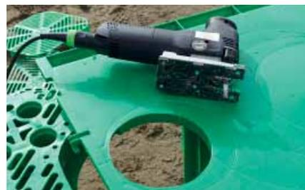
Je nach Einsatzzweck können Sie die jeweilige Öffnung durch eine Drehung von 180° oben oder unten an einem Rigolenelement positionieren. Die Anschlussplatte wird wie bei den Seitenwänden
