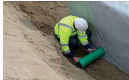
Die Baugrube verfüllen Sie nach Fertigstellung der Rigolenanlage erst seitlich und überdecken sie zum Schluss.
