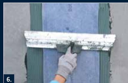
6. Botament FB Fugendichtband in die frische Abdichtung einbetten und die Dichtbandränder überarbeiten
