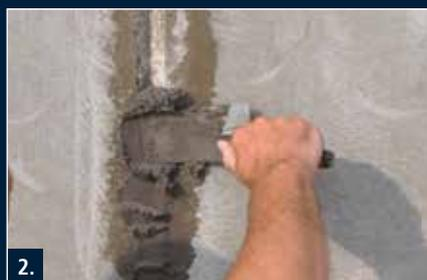
2. Fugen mit Botament M36 Speed verschließen
