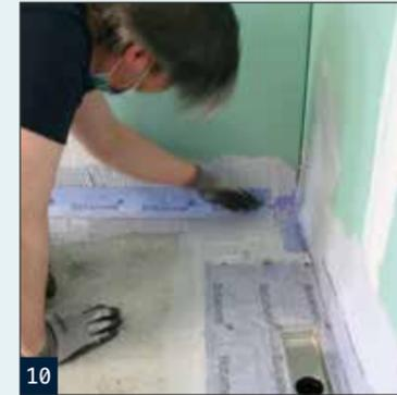
10 Einarbeiten der SB78 Dichtbänder in Multiproof.
