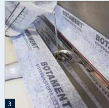
3 Angeschlossen Linienentwässerung auf Dichtigkeit prüfen.
