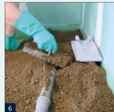
6 Unterfüttern des Rinnenkörpers mittels M 54 FM Schnellestrich-Fertigmörtel.
