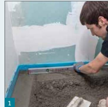
1 Erstellung der Estrich-Abziehlen aus M54 FM Schnellestrich-Fertigmörtel.
