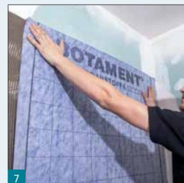
7 Verlegen von AE Abdichtungs- und Entkoppelungsbahn mit M21 Classic, M21 HP Premium Flex-Schnellkleber oder M21 HP Speed im Wandbereich.
