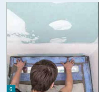
6 Einarbeiten von SB78 Sanitärabdichtband in M21 Classic, M21 HP Premium Flex-Schnellkleber oder M21 HP Speed.
