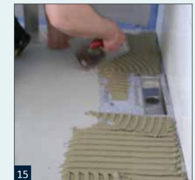
15 Auftragen von geeignetem Botament Fliesenkleber.
