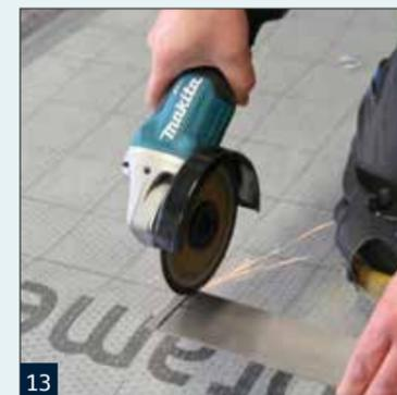
13 Optional: Variables ablängen der Water LD V mittels langsam laufender Flex mit entsprechend geeigneten Trennscheiben.
