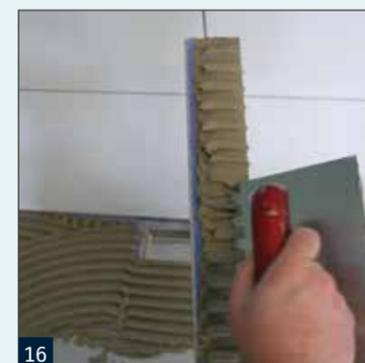
16 Auftragen von Fliesenkleber auf der Profilrückseite.
