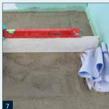
7 Erstellen eines Gefällestrichs mit ausreichendem Gefälle.
