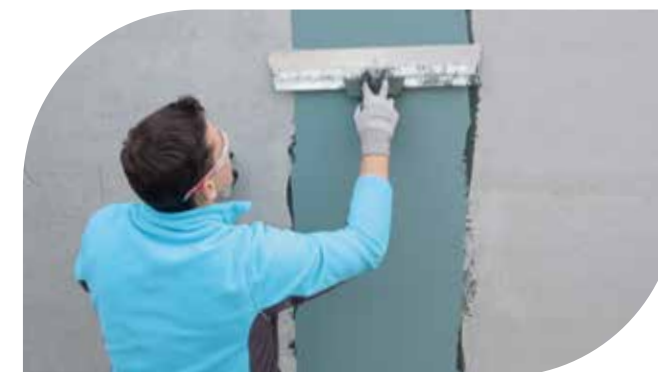
Streifenabdichtung bei WU-Betonkonstruktionen
