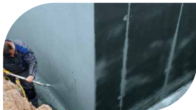
Abdichtung auch bei großen Flächen und in großen Schichtdicken
