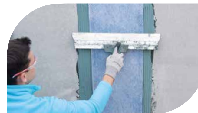
Fugenabdichtung und Abdichtung von WU-Betonbauteilen
