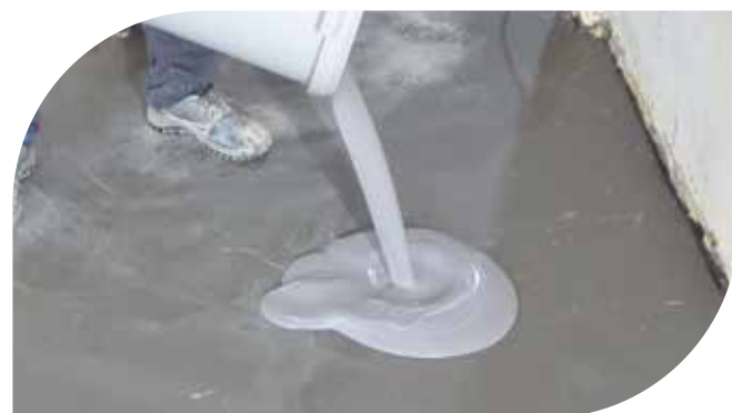
Abdichtung von erdberührten Bodenplatten – Sanierung
