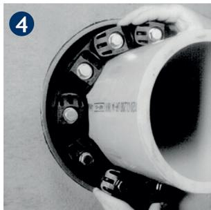
**4** Schieben Sie den Ring in den Zwischenraum. Die Schraubköpfe sollen auch nach der Montage zugänglich sein. Bei Ketten mit größeren Dichtelementen schieben Sie zuerst den Ring auf 6.00 Uhr Position ein und dann auf beiden Seiten bis zur 12.00 Uhr Position.
