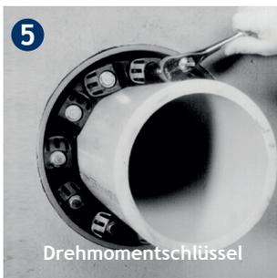
**5** Beginnen Sie nun auf 12.00 Uhr Position die Schrauben im Uhrzeigersinn anzuziehen. Anziehen nur mit der Hand, nicht mit Maschinenschraubern (Drehmomentschlüssel).
