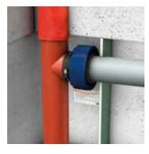
Abschottung von Decken aus Stahlbeton, Beton, Porenbeton mit einer  $Dicke \geq 150 \ mm$
