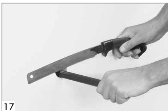
Das überstehende Rohr wird unter Zuhilfenahme einer Säge wandbündig eingekürzt.
