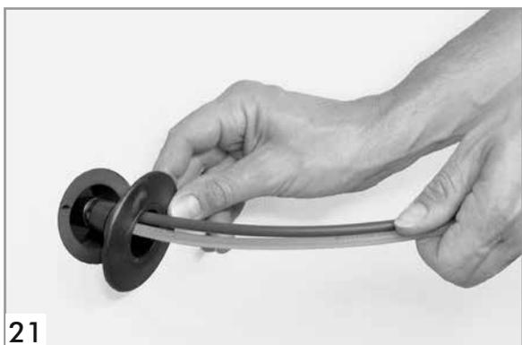
Wandabschlussrosette auf der Gebäudeinnenseite über die SpeedNet-Rohre führen und bis auf Anschlag über das Einführungsrohr schieben.
