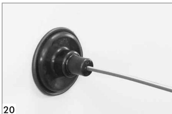
Anschließend werden die SpeedNet-Rohre von der Gebäudeaußenseite durch die beiden Bohrungen des Außenflansches geführt.
