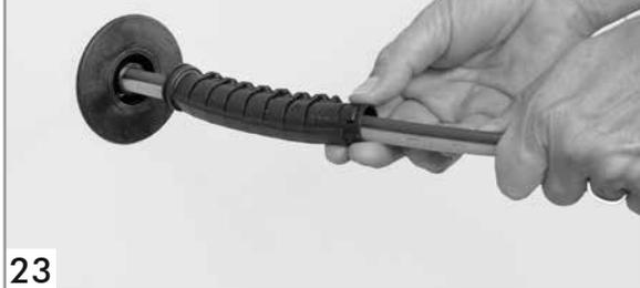
Rasterbogen auf der Gebäudeinnenseite über die SpeedNet-Rohr schieben und bis auf Anschlag auf das Einführungsrohr stecken.
