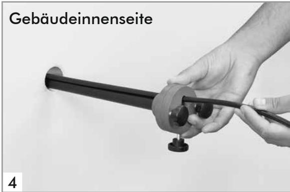
Anschließend die entspannte Schnellspannvorrichtung auf das Quadro-Sicura® MIS-Rohr führen. Der Harzinjektionsschlauch wird dabei in der Öffnung oben geführt.
