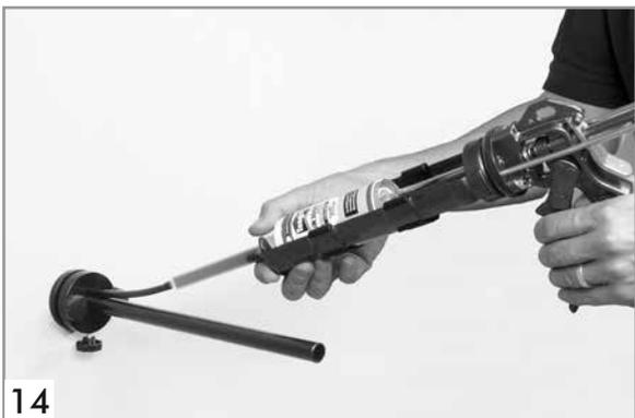
Harzkartusche in Kartuschenpistole einlegen. Mit gleichmäßigen Bewegungen an der Kartuschenpistole das Harz komplett aus der Kartusche in die Quadro-Sicura® MIS injizieren. **Wichtig!**
