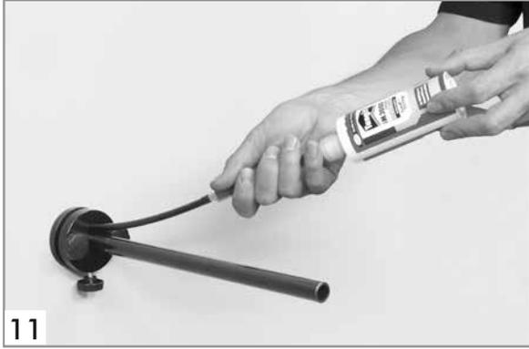
Verschlussdeckel der Harzkartusche (Tangit iM3000, 150 ml) abschrauben und Kartusche in die Mischdüse einschrauben.
