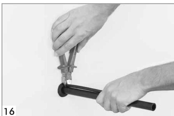
Nach Ablauf der Aushärtezeit muss das wiederverwendbare Schnellspannsystem entfernt werden. Danach wird der Harzeinfüllschlauch mit Hilfe eines Seitenschneiders wandbündig abgetrennt.
