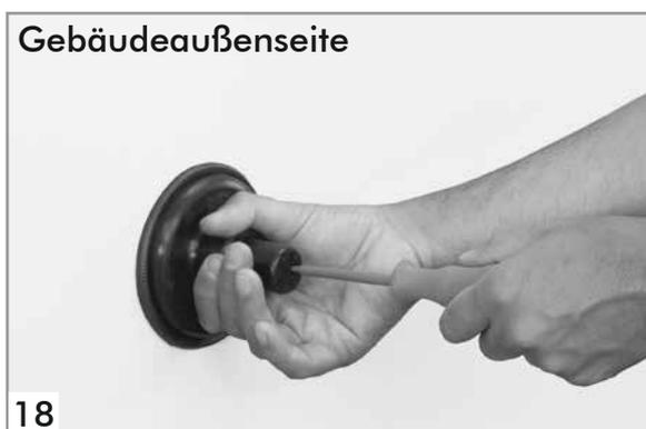
Von der Gebäudeaußenseite kann nun mit einem geeigneten Werkzeug (z.B. Kreuzschlitzschraubendreher) die Membranen der beiden Einführöffnungen durchstoßen werden.
