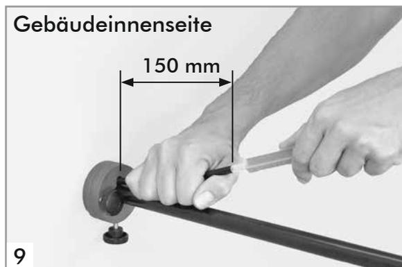
Den Harzeinfüllschlauch unter Zuhilfenahme eines Seitenschneiders auf 150 mm (gemessen ab Gebäudeinnenwand) ablängen (kürzerer Schlauch bedeutet leichteres Füllen). Danach Mischdüse mit Harzeinfüllschlauch bis zum Anschlag fest verbinden.
