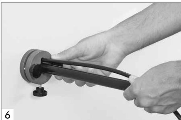
Durch das Festziehen der beiden axialen Schrauben auf Anschlag wird die Quadro-Sicura® MIS gegen die Außenwand verspannt.
