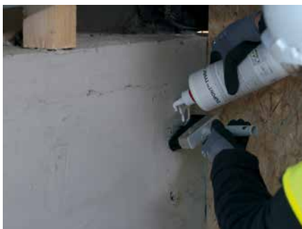
4. Verwenden Sie Tyvek® Primer, um die Oberfläche zu stabilisieren und die Haftung vor dem Auftragen des Klebebands zu verbessern
