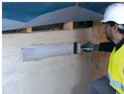
5. Tyvek® Primer mit einer Dicke von 1 mm auf die Oberfläche auftragen
