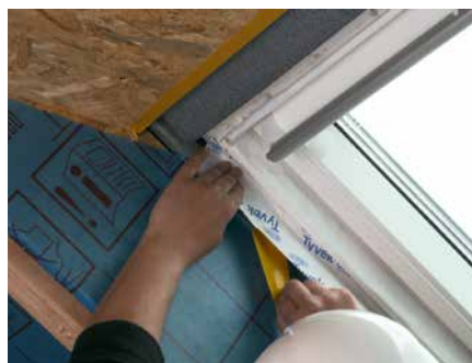
6. Verbinden Sie den schmalen offenliegenden Teil des Klebebandes mit dem Fensterrahmen
