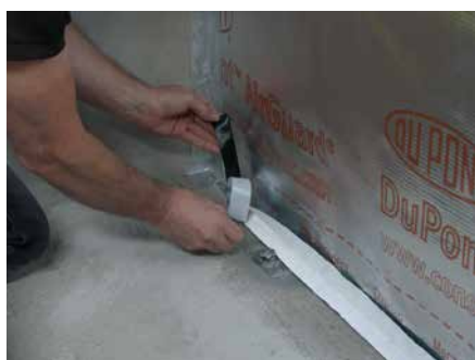
7. Ziehen Sie die obere Trennfolie ab und bringen Sie es in die gewünschte Position. Entfernen Sie den Rest der Trägerfolie und drücken Sie das Klebeband sofort gegen die Bahn an der Wand
