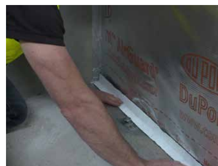
6. Bringen Sie Tyvek® FlexWrap EZ an der Ecke zwischen Wand und Boden an
