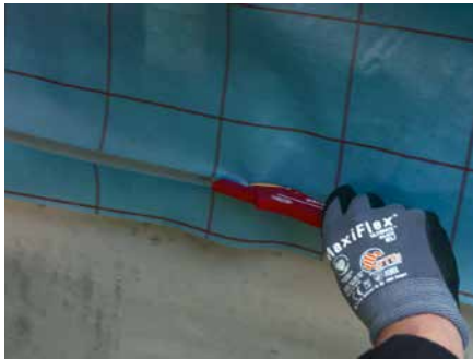
1. Schneiden Sie die Bahn passend zurecht
