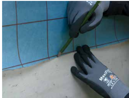
2. Markieren Sie, wo der Tyvek® Primer aufgetragen werden soll
