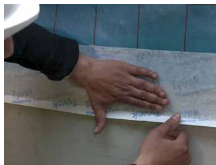
11. Entfernen Sie das zweite Stück Trennfolie. Falten Sie es auf die grundierte Oberfläche und üben Sie Druck auf seiner gesamten Länge aus
