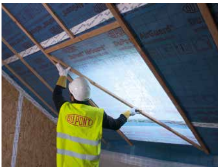
1. Schneiden Sie mit Hilfe einer Holzlatte ein "Y" in die Bahn.
