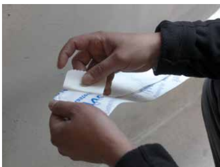
10. Ziehen Sie ein kurzes Stück der zurück gefalteten Trennfolie ab und legen Sie das freiliegende Klebeband auf die Dampfbremse. Entfernen Sie den Rest der Trennfolie und drücken Sie das Klebeband dabei fest an
