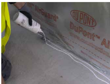
2. Verwenden Sie Tyvek® Primer zur Vorbereitung der Oberfläche für eine bessere Haftung.
