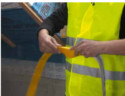
5. Verwenden Sie Tyvek® Akrylat Klebeband 60 mm mit geteilter Trennfolie, falten Sie es zuerst an der Teilung, ziehen Sie die schmale Trennfolie ab.
