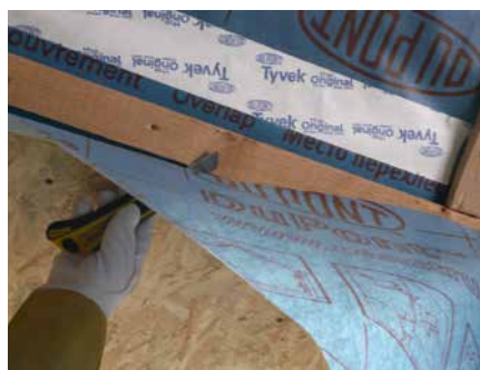
3. ... und der Kante der oberen Fensterlaibung zu.
