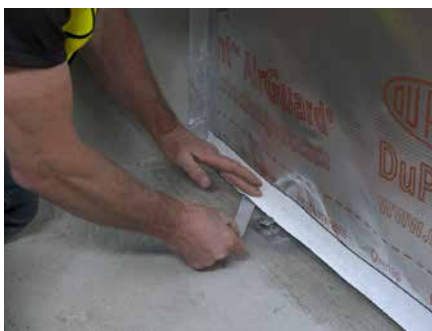
8. Verfahren Sie genauso mit der unteren Trennfolie und drücken Sie sie fest auf den Boden, wobei Sie große Falten ausgleichen, um sicherzustellen, dass die Verklebung luftdicht ist
