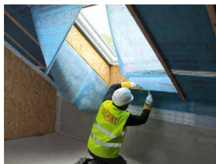
2. Schneiden Sie die Bahn bündig mit der Kante der unteren Fensterlaibung ...
