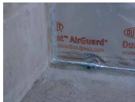
3. Der weiße Tyvek® Primer wird nach einer Stunde transparent und kann dann verwendet werden
