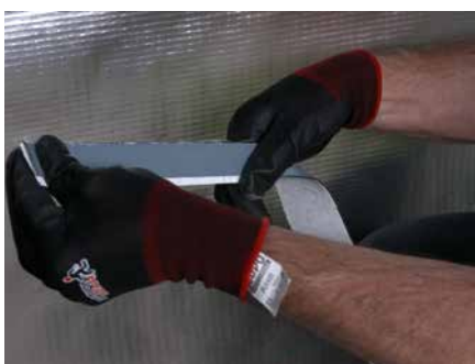
5. Falten Sie es in der Mitte über die gesamte Länge des Klebebandes.
