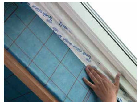
7. ...und drücken Sie es fest. Versuchen Sie, das Band so glatt wie möglich aufzutragen, indem Sie Knicke und Falten so weit wie möglich vermeiden. Wiederholen Sie den Arbeitsvorgang an der anderen Seite des Fensters.
