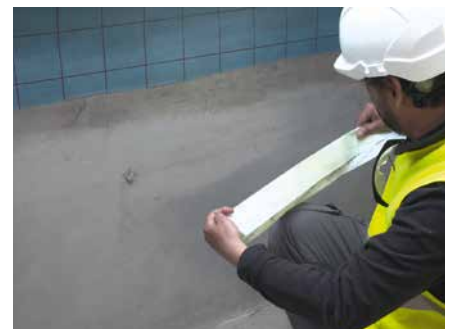
9. Verwenden Sie Tyvek® Putzanschluss-Klebeband 150 mm und falten Sie das Band entlang der ersten Teilung der Trennfolie zurück
