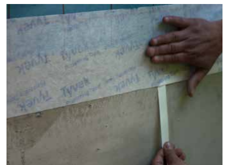
12. Entfernen Sie den Rest der Trennfolie, drücken Sie das Klebeband fest an und glätten Sie es
