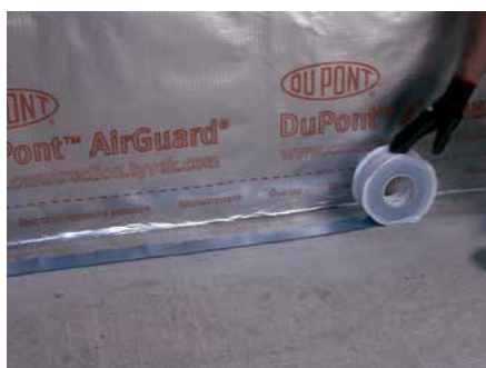
4. Messen Sie die erforderliche Länge Tyvek® FlexWrap EZ ab und schneiden Sie es zurecht
