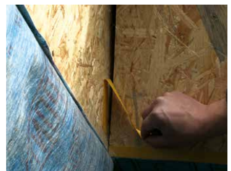
4. Entfernen Sie die Trennfolie von dem Tyvek® doppelseitigen Klebeband 20 mm und drücken Sie den Rest der AirGuard® Dampfbremse gegen die Holzstruktur, schneiden Sie überstehendes Material ab.
