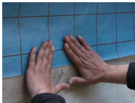
8. Klappen Sie die Dampfbremse wieder herunter auf die vorgeprimerte Fläche
