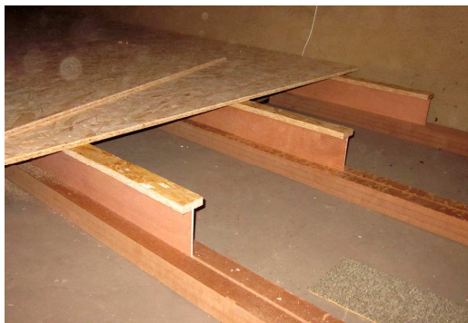
DP mit SE und OSB-Boden
