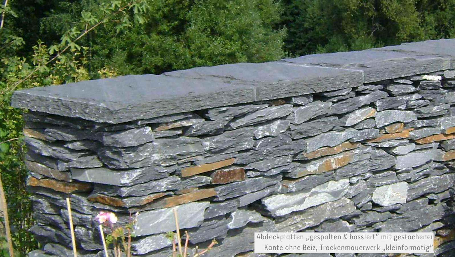
Abdeckplatten „gespalten & bossiert“ mit gestochener Kante ohne Beiz, Trockenmauerwerk „kleinformig“
