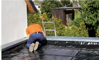
**1+2** Aufbringen der Wurzelschutzfolie (falls Dachabdichtung nicht wurzelfest). Sie wird bis unter die Blechabdeckung geführt. Anschließend folgt eine Speicherschutzmatte.
