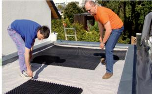
**3** Auf der Speicherschutzmatte werden dann die Drainage-Elemente Floradrain® FD 25 ausgelegt. Sie speichern Niederschlagswasser für trockene Tage und führen überschüssiges Wasser sicher ab.
