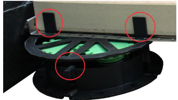
Abbildung 6: Anwendungsbsp. VOLFI-ZRV mit WAE-K. Für die Verlegung im Randbereich werden 2 gegenüberliegenden Fugenstege entfernt. Anschließend kann der Wandabstandhalter einfach in die I-Fuge des Stelzlagers eingelegt werden.
