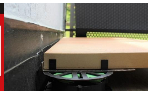
Abbildung 4: VOLFI-ZRV mit Wandabstandhalter WAE-K für eine saubere Fuge im Randbereich
