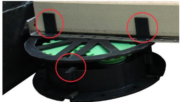
Abbildung 7: Anwendungsbsp. VOLFI-ZRV mit WAE-K. Für die Verlegung im Randbereich werden 2 gegenüberliegenden Fugenstege entfernt. Anschließend kann der Wandabstandhalter einfach in die I-Fuge des Stelzlagers eingelegt werden.
