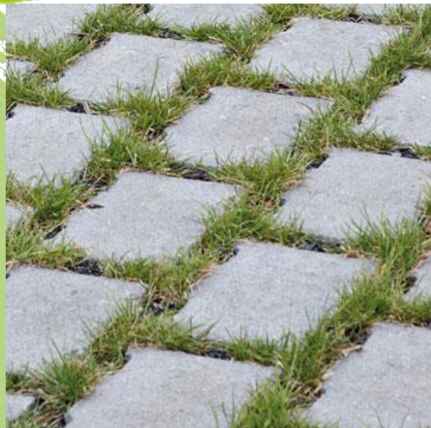
Abbildung 4: Beispiel Verlegte Fläche
