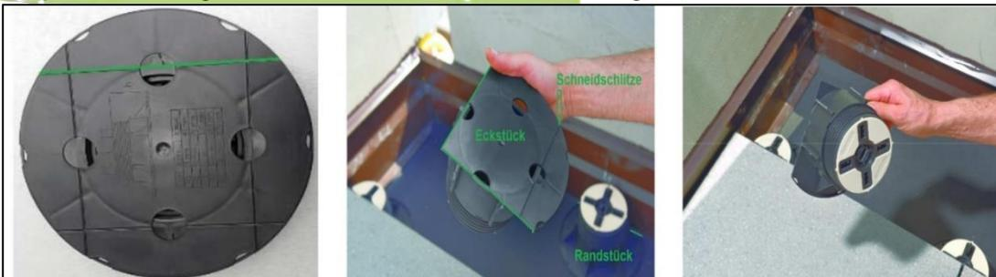
Abbildung 8: Verlegung im Rand- und Eckbereich. Vorgefertigte Schneidschlitzte im Unterteller ermöglichen einfache Anpassung des Stetzlagers
