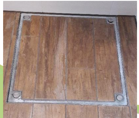
Abbildung 2: SA-VB feuerverzinkte Schachtabdeckung, eckig im Badezimmer verlegt, belegt mit Fliesen über Zisterne
