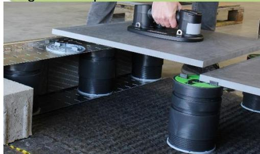
**Je nach Einbausituation wird empfohlen das Unter- und/oder Oberteil für mehr Stabilität punktwise anzukleben. Dies ist z.B. vom aufliegenden Plattengewicht abhängig.**
