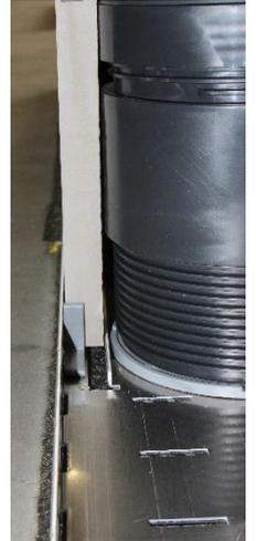
3. Das Oberteil wird anschließend auf die Stelzlager aufgelegt, während die Platten gleichzeitig in dem U-Profil gehalten werden. (Montage mögl. zu 2 Personen durchführen)
