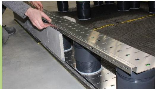
4. Der waagrecht aufliegende Plattenbelag wird dann mit Hilfe von hochwertigen gummierten Randstücken VP-GKUI auf dem Stufenprofil Oberteil verlegt. Bei 20mm Platten wird eine exklusive, passgenaue Optik erreicht.
